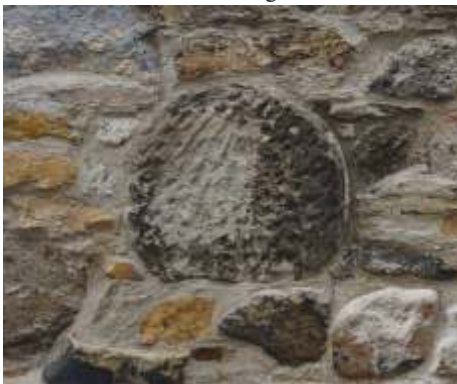
Die Kirchhofmauer mit der eingemauerten Kugel in der Pfarrstraße. Der sichtbare Durchmesser beträgt 51 cm. Im linken Teil ist die originale Steinfarbe zu erkennen.
